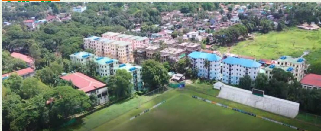
公寓建设开发区
